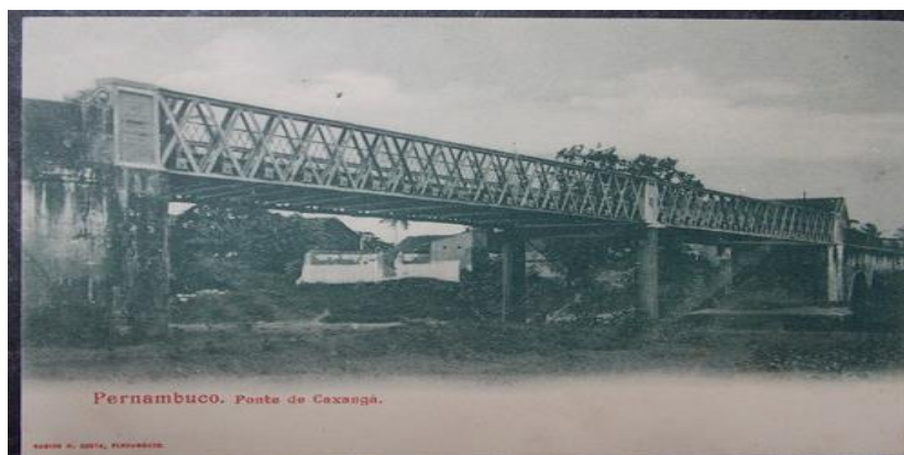
Figura 1 – Ponte Pênsil da Caxangá no final da Avenida, década de 1870
