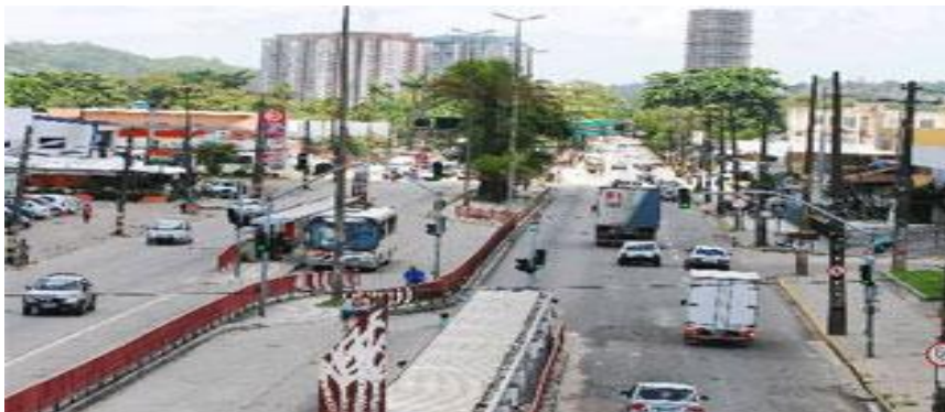
Figura 5 – Av. Caxangá durante as obras de implantação de estação de passageiros do corredor Leste/Oeste
