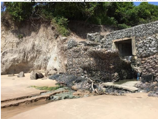
Figura 39. Galeria pluvial direto no mar
