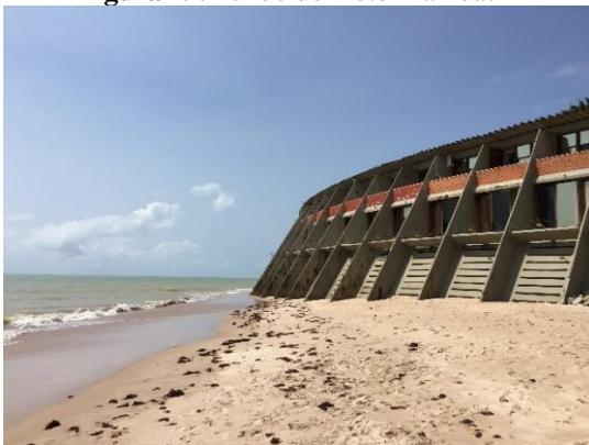
Figura 19. Fundo do Hotel Tambaú
