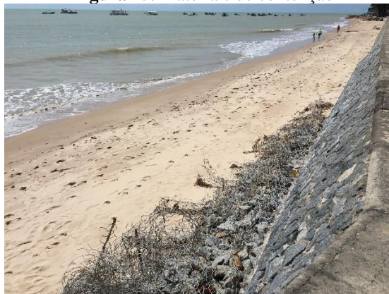
Figura 15. Materiais de contenção
