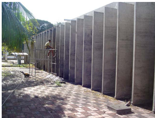
Limpeza externa do Bloco Administrativo
