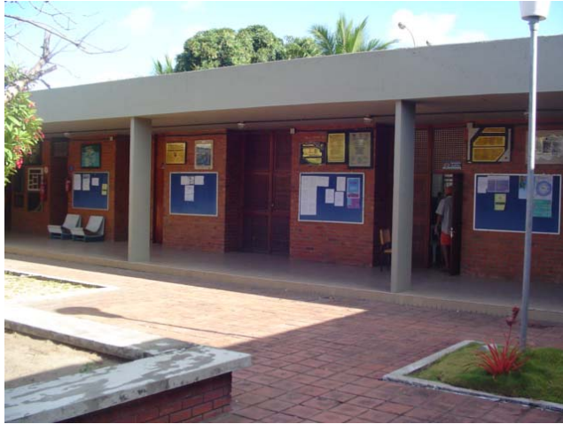
Limpeza e pintura internas do Bloco Administrativo
