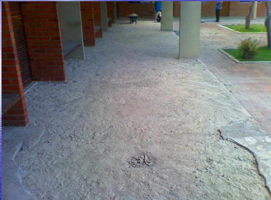
Administração – Novo piso do corredor (cont.)
