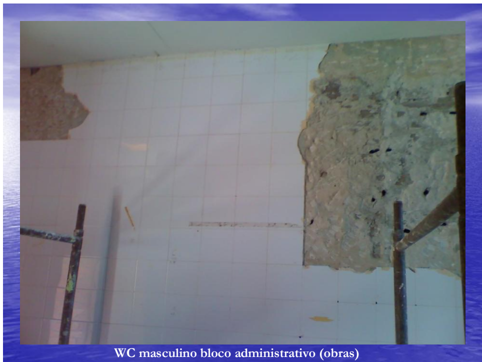
WC masculino bloco administrativo (obras)
