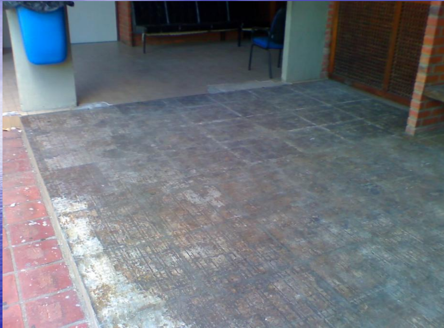
Administração – Novo piso do corredor (cont.)
