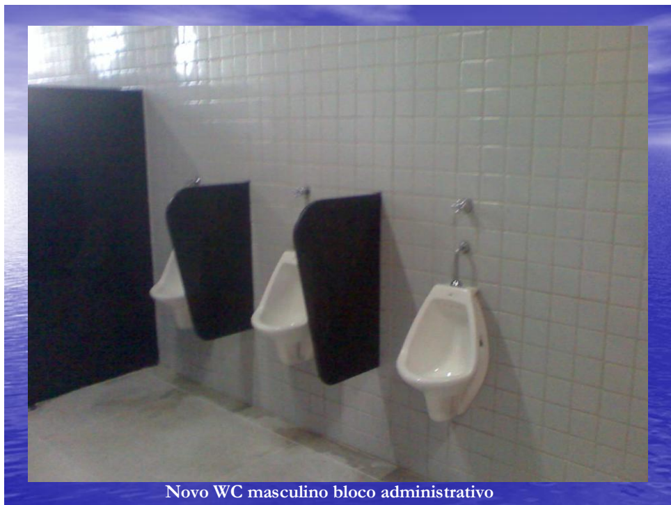
WC masculino bloco administrativo (obras)
