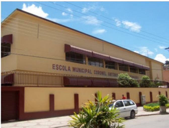
IMAGEM 07: Escola Municipal Coronel Antônio da Silva Bernardes, Viçosa, MG. Edifício tombado pelo município no ano de 2004. Fotografia: web. Autor desconhecido.
