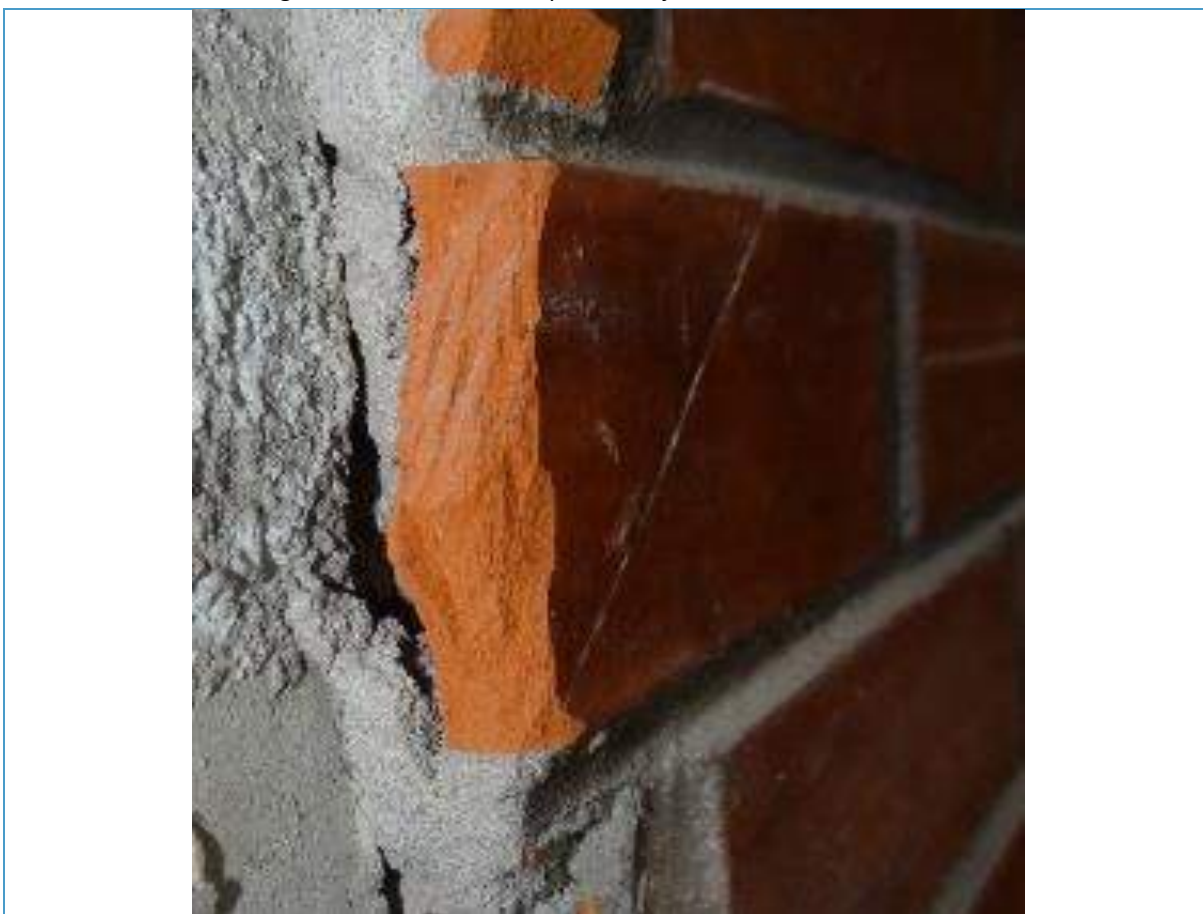
Figura 11 - Detalhe do casquilho de tijolo recobrindo a estrutura
