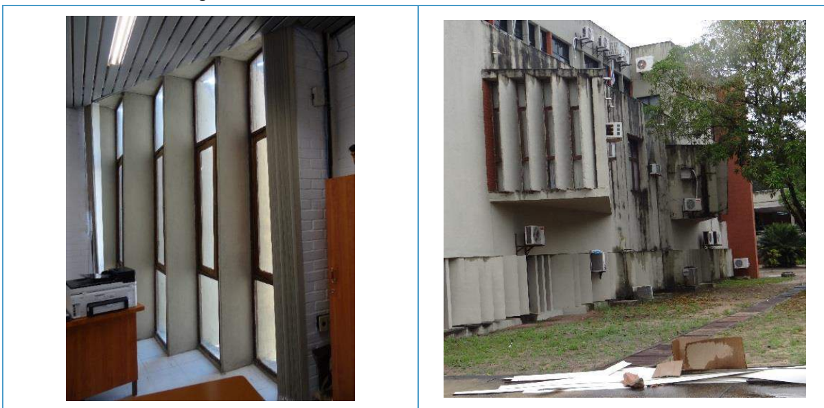
Figura 10: Vista externa dos Brises da fachada Noroeste, 2017.
