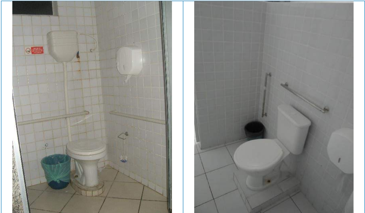
Figura 19 - Foto da cabine acessível do WC norte, primeiro pavimento da Reitoria Figura 20 - Cabine acessível do WC norte, pavimento térreo da Reitoria
