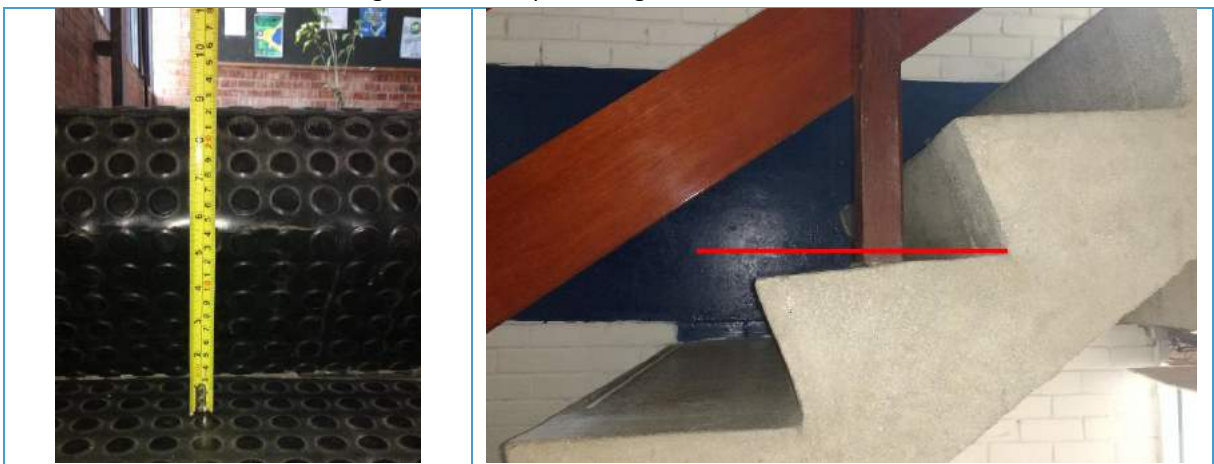
Figura 22 - Exemplo de degrau fora das normas
