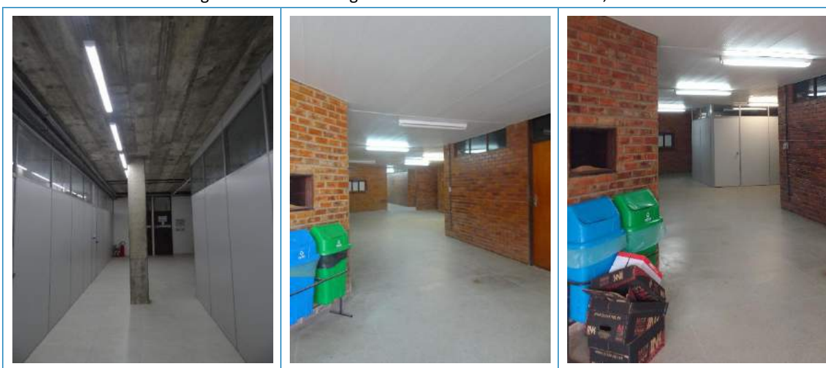
Figura 16 - Área do segundo andar - foto tirada em abril, 2018.
