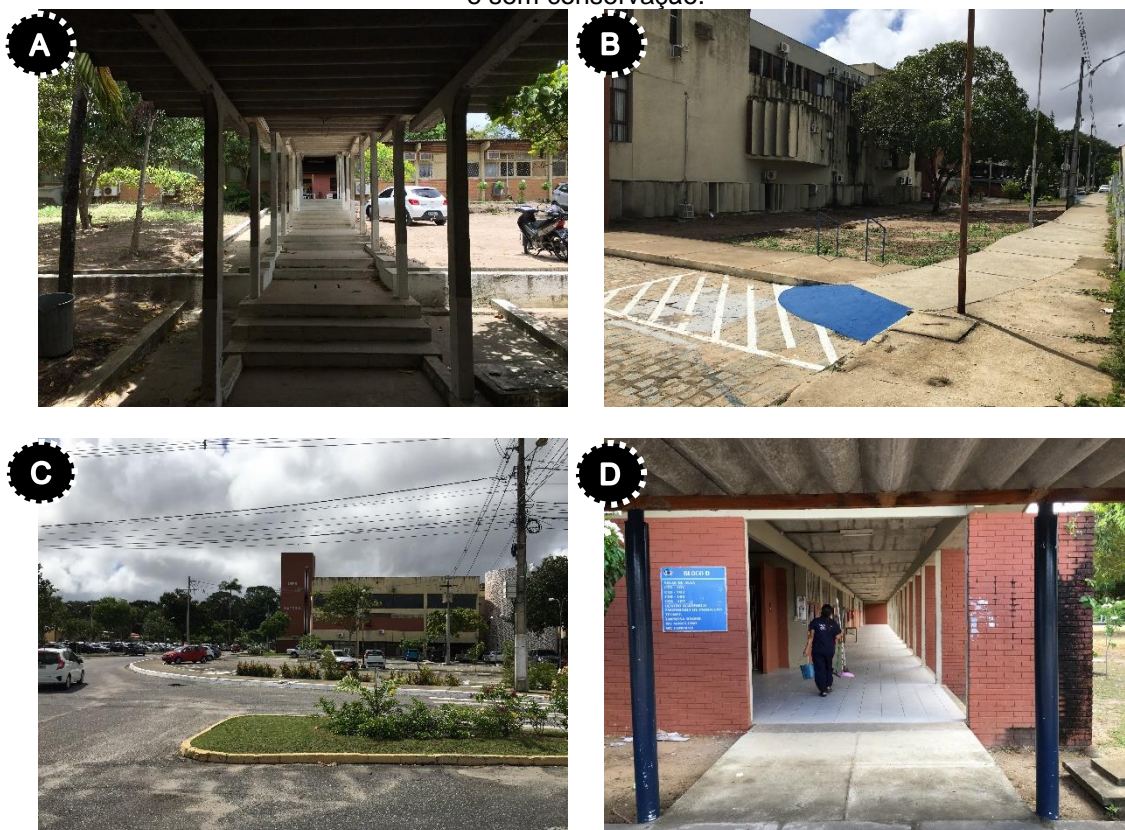
Figura 29: Estruturas de passarelas cobertas e pavimentação de calçadas danificadas, interrompidas e sem conservação.
