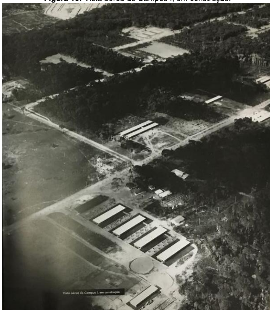
Figura 19: Vista aérea do Campus I, em construção.
