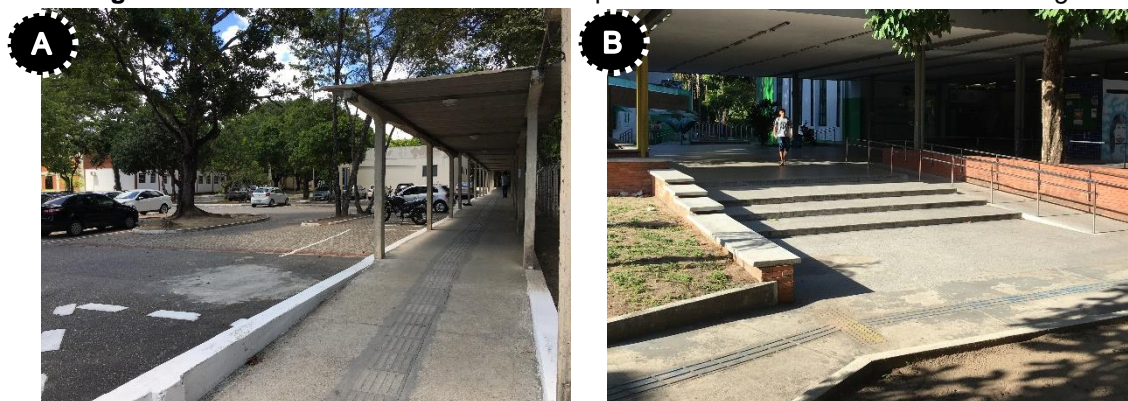
Figura 34: Pisos Táteis referentes ao Campus I encontrados durante o Walkthrough .
