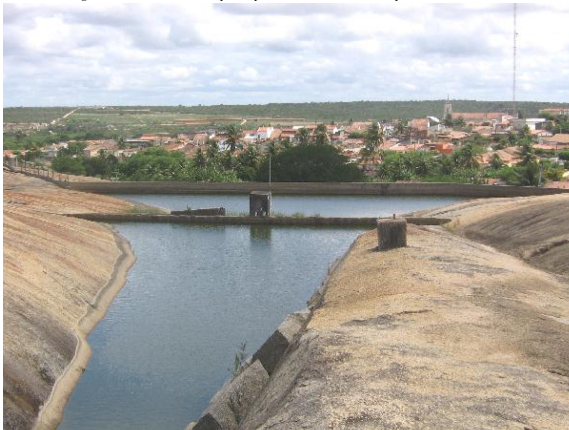
Figura 16 - Estrutura do tanque de pedra localizado no município de Pocinhos - PB.
