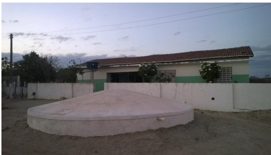
Fotografia 7 - Cisterna Escolar na zona rural do município de Teixeira - PB.
