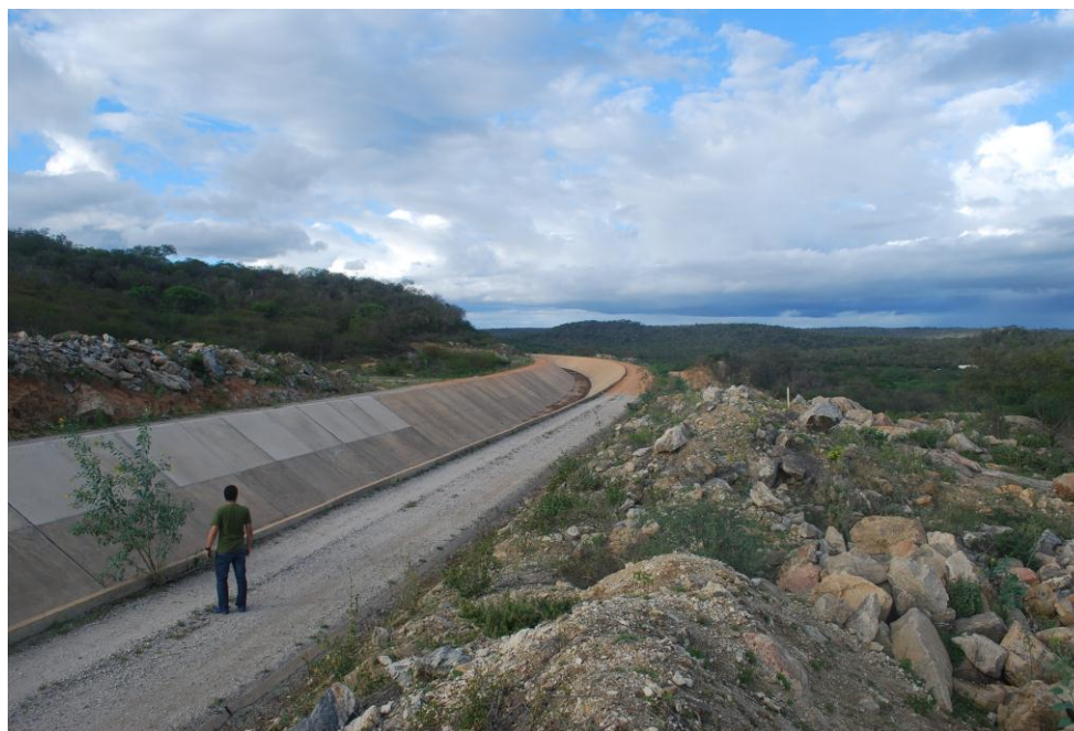
Fotografia 1 - Canal do Eixo Leste no município de Sertânia - PE.
