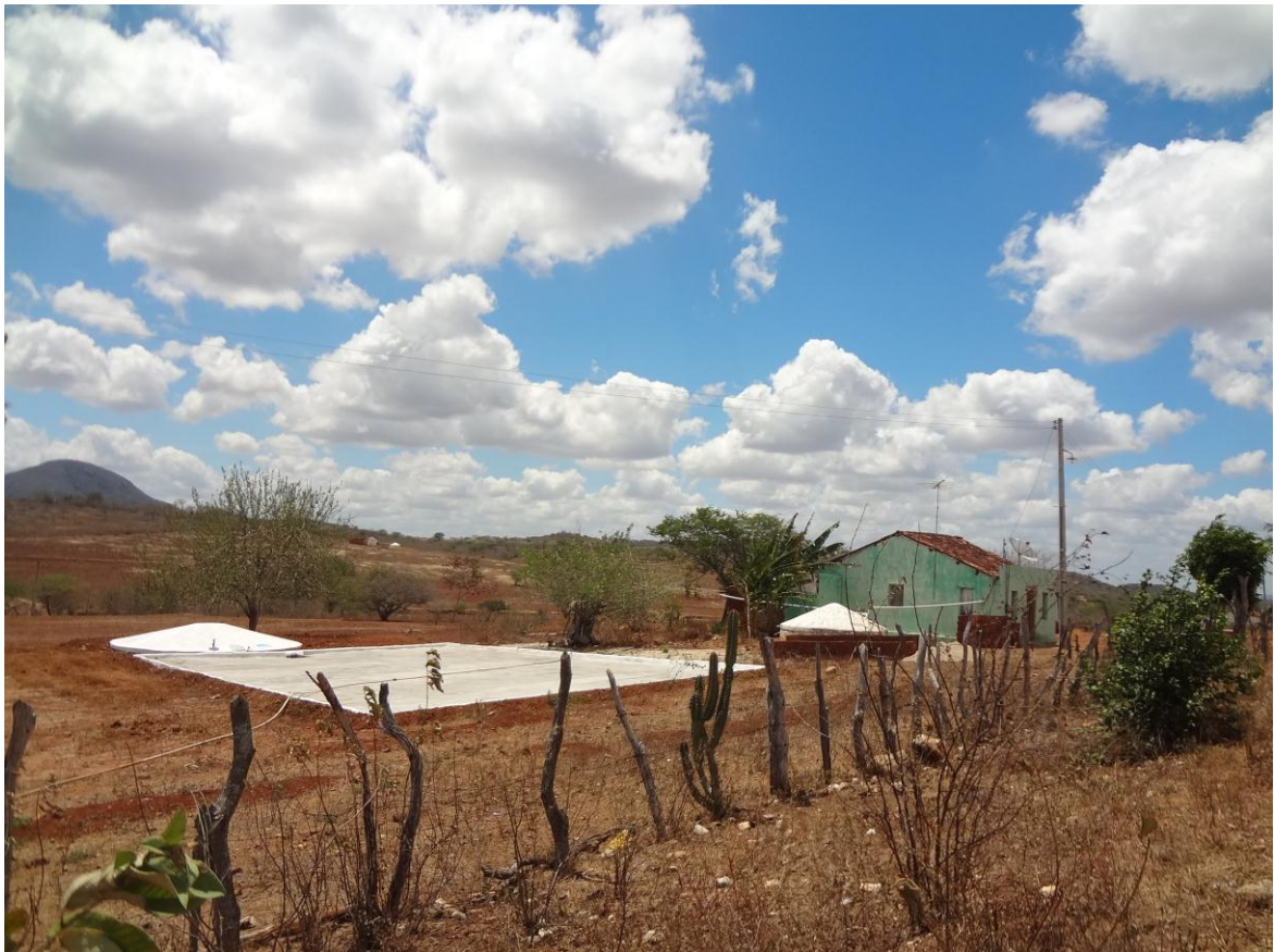
Fotografia 9 - Cisterna calçadão na zona rural do município de Boqueirão - PB. Ao fundo cisterna de placa junto a residência.
