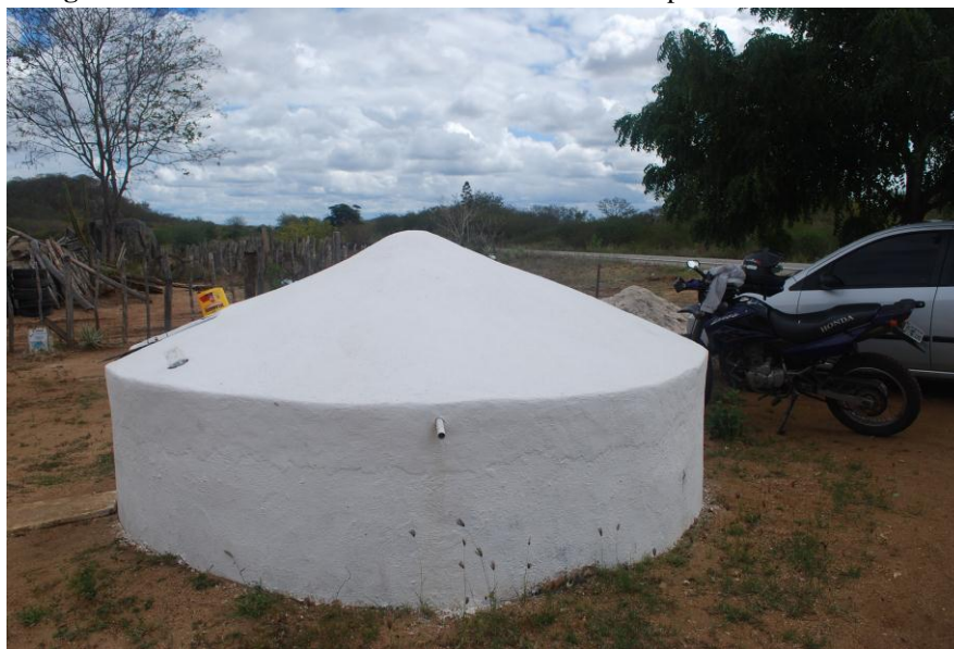
Fotografia 8 - Cisterna de Placa na zona rural do município de Serra Branca - PB.
