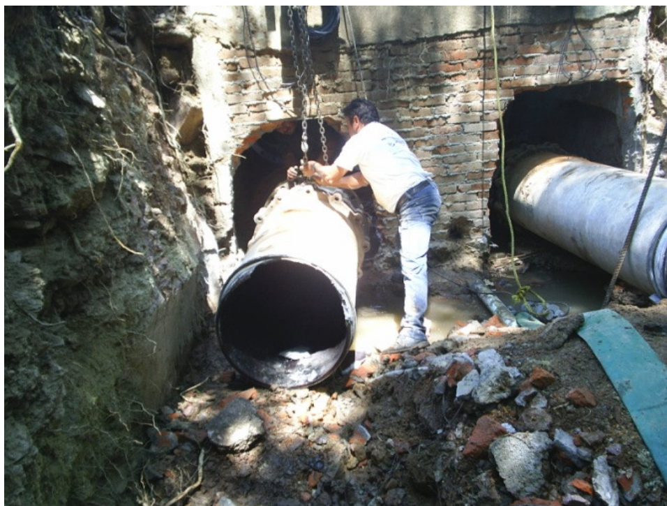
Figura 1.- Adecuación de instalación y sustitución de tubería
