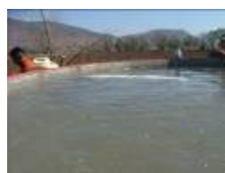
Llenado del tanque TDF
