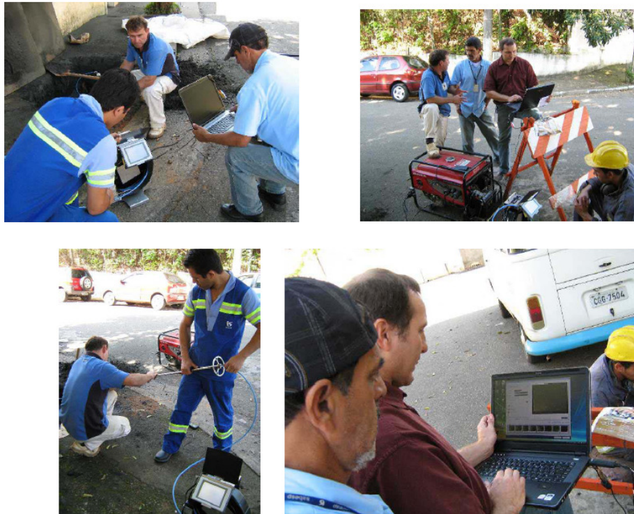
Figura 5. Inspeção televisa da rede após o término da limpeza da tubulação.
