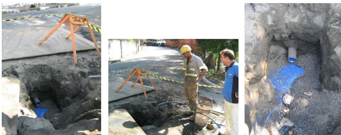
Figura 7. Serviços de revestimento da rede com aplicação de resina epóxi.
