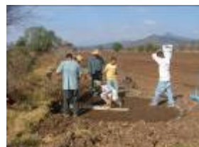
Relleno y nivelación del terreno
