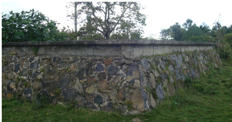
Capacidad: 135m 3 ; Dimensiones: 8.2m x 8.2m x 2m aproximadamente
