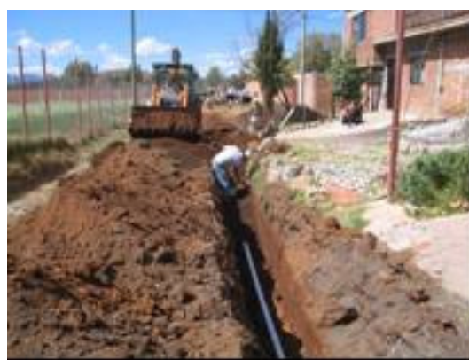
Figura 5.- Impermeabilización del tanque ICATMI e instalación de tubería de 2 ½"
