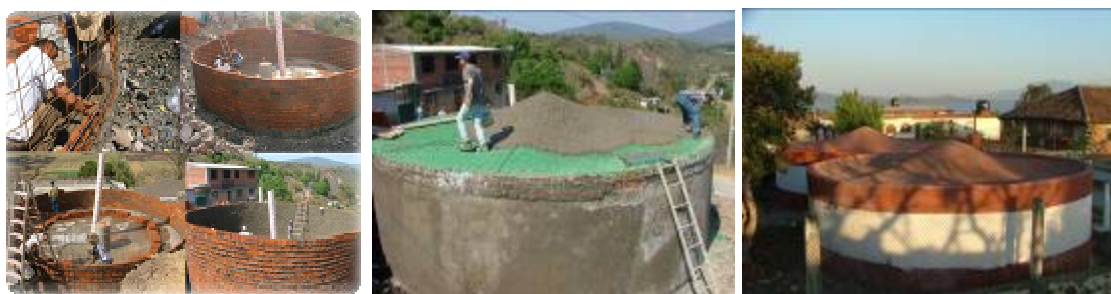
Ilustración 1. Cisterna de 100,000 litros, cilíndrica tipo capuchina, tiempo de construcción 8 días, 2,500 USD de materiales.
