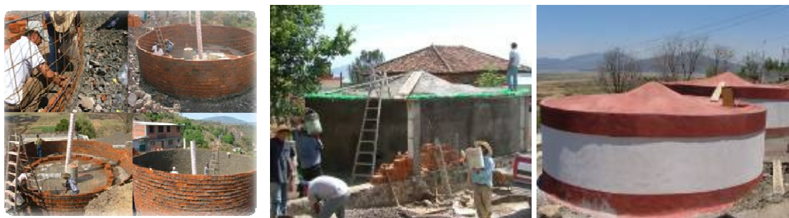
Ilustración 1. Cisterna de 100,000 litros, cilíndrica tipo capuchina, tiempo de construcción 8 días, 2,500 USD de materiales.
