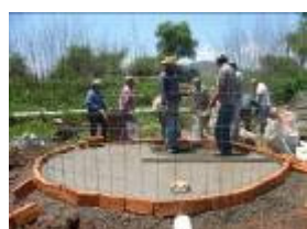
Colado del fondo
