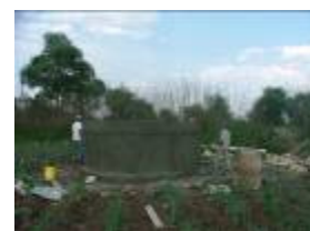
Armado del fondo y cilindro del tanque
