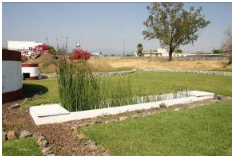
Figura 7. Humedal de tratamiento del agua residual.
