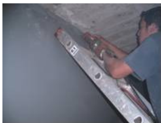
Figura 5.- Impermeabilización del tanque ICATMI e instalación de tubería de 2 ½"
