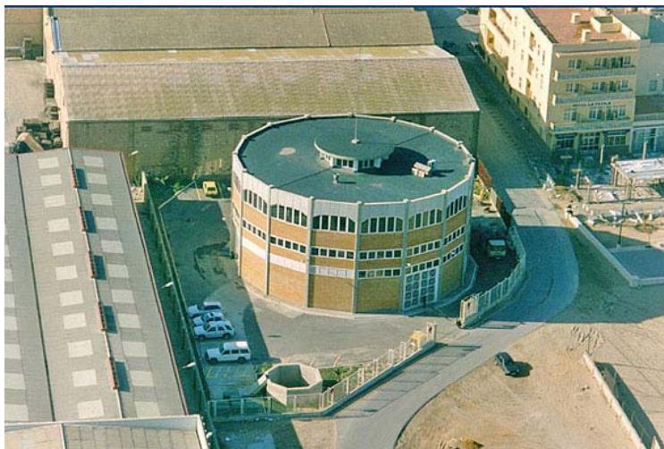
Figura 8. Vista de la Estación de Bombeo de El Cabañal.
