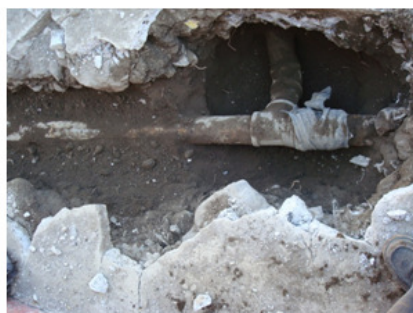
Sondeo realizado para verifiacar el cruce, mismo que no se encuentra igual como indica el plano.
