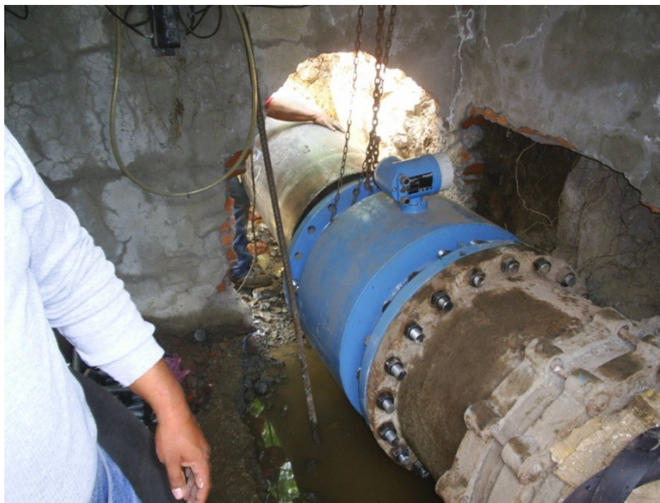
Figura 2.- Colocación del carrete con medidor de flujo.
