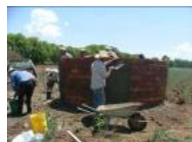
Repellado de paredes
