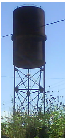
Fotografía 2 Vista actual del tanque
