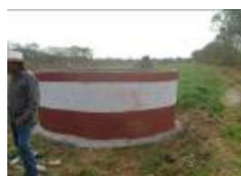
Tanque TDF terminado
