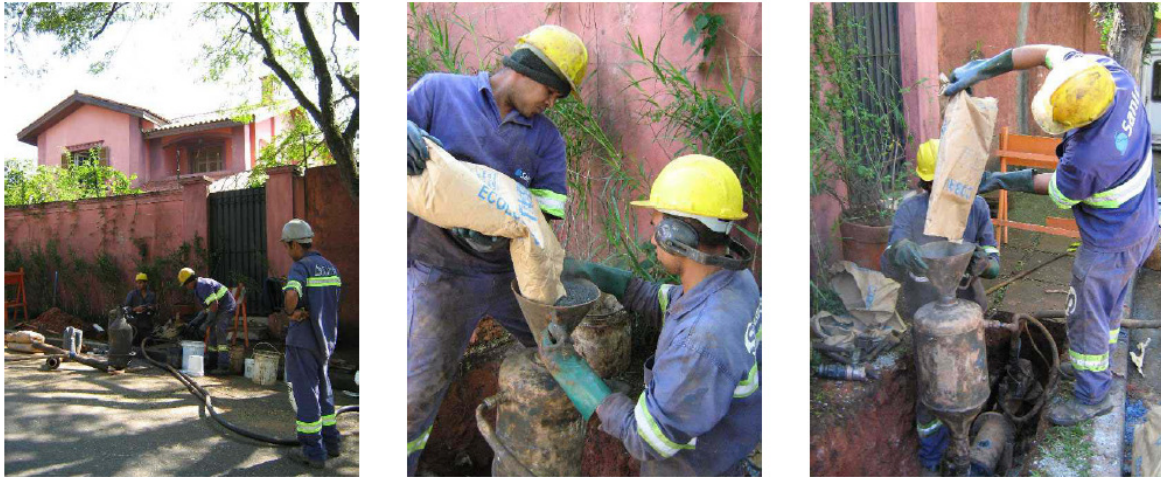
Figura 4. Serviços de limpeza da rede por turbilhamento.
