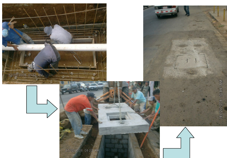
Figura 11: Construcción de la cámara de entrada a un sector hidráulico.
