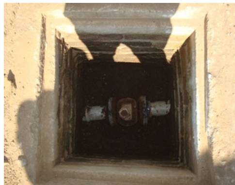
Después del desazolve y mantenimiento
