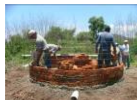
Levantamiento de muro capuchino
