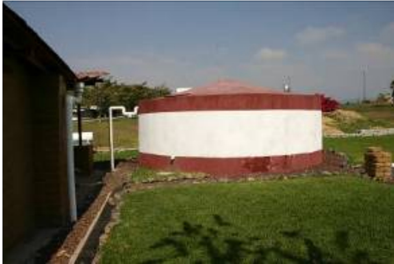
Figura 5. Captación de agua de lluvia.
