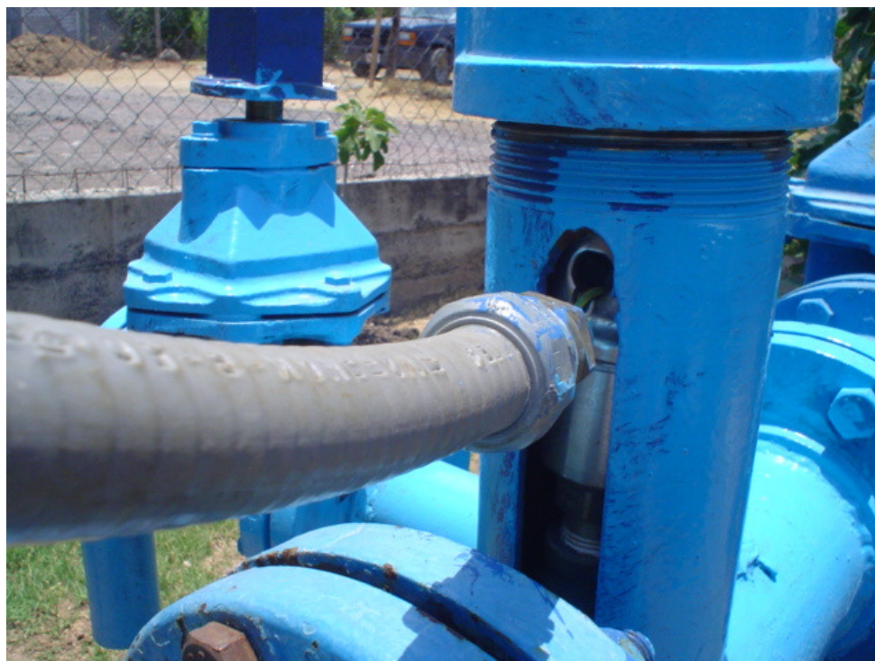
Figura 11.- Protección de sensor de presión.
