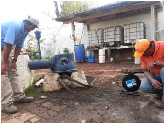
Nivel dinámico con sonda
