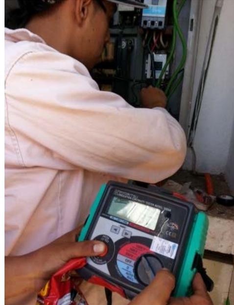
Medición de voltaje, amperaje y resistencia
