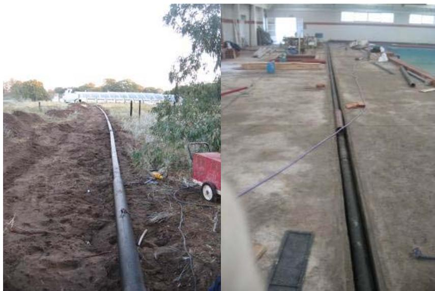
Figura 6. Instalación de cañería dentro del natatorio
