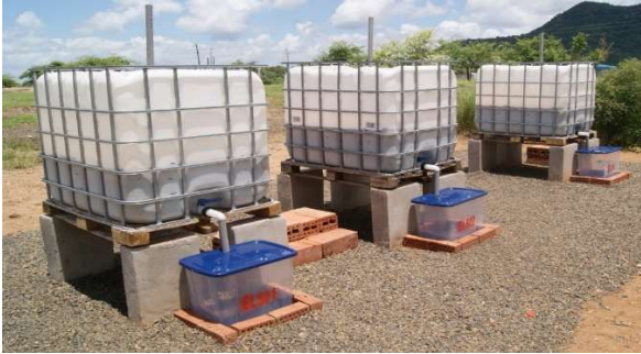
Figura 1. Instalação-piloto de tratamento de lamas na cidade de Tete, Moçambique
