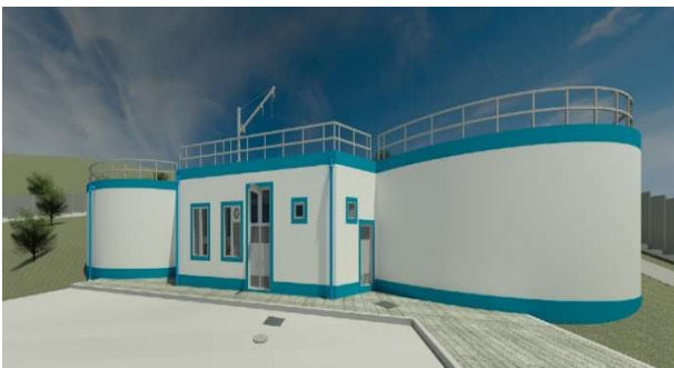
Figura 5. Vista exterior do reservatório
