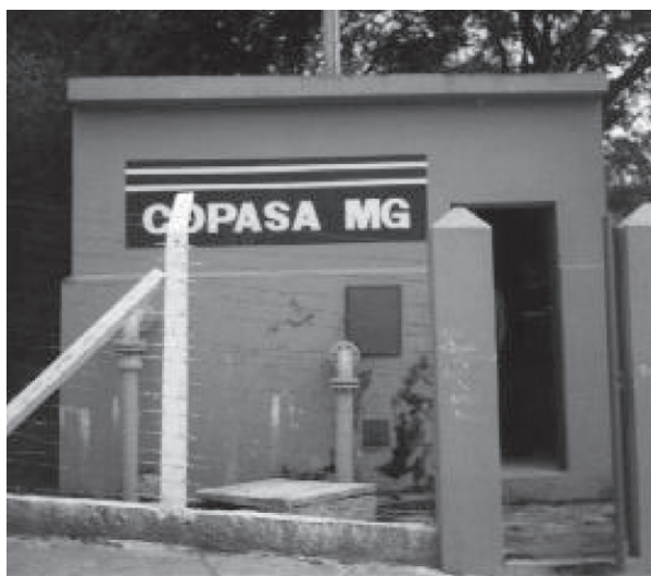
Figura 3.32 Casa de máquinas da Estação Elevatória
