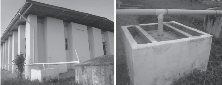
Figura 5.10 Dispositivo de descarte de derivação direta do tubo condutor
