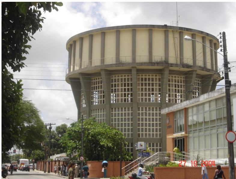
Figura 5.6 - Reservatório elevado (RE) do sub-sistema R1.
