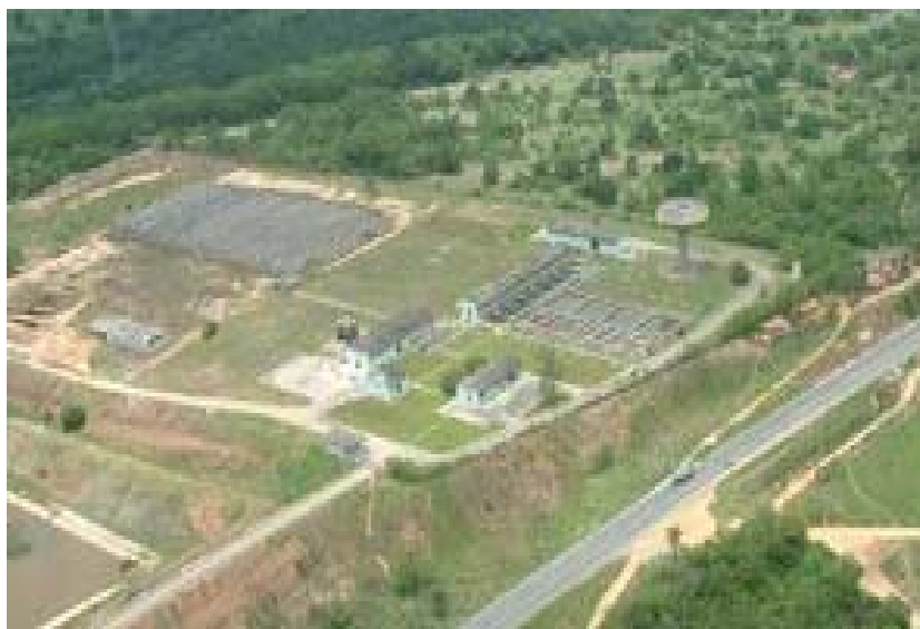
Figura 3.2 - Estação de Tratamento de Gramame
