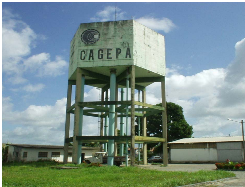
Figura 3.3 - Reservatório elevado R-7
