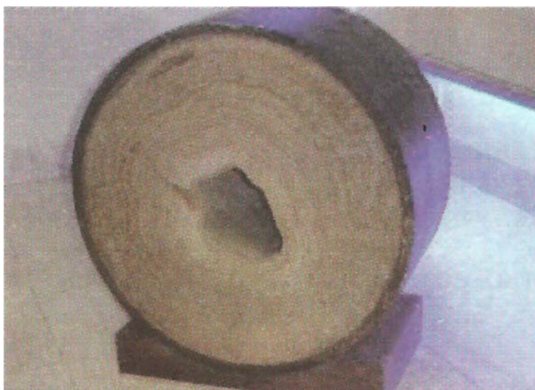
Figura 2.5 - Tubulação com diminuição da seção transversal
