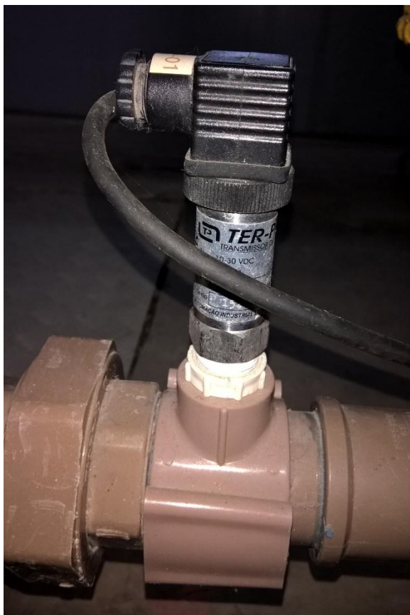
Figura 4.4 - Transdutores de pressão
