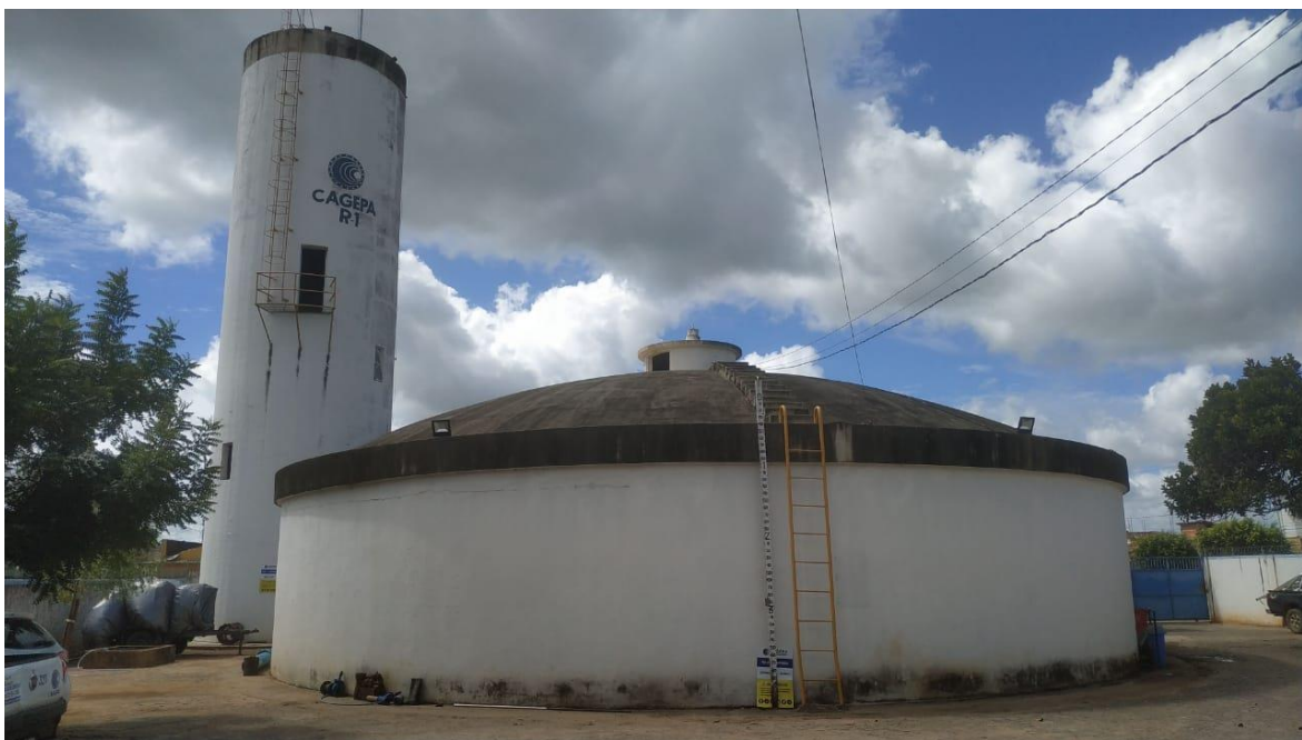
Figura 4.6 – Reservatório R1 apoiado e em segundo plano o reservatório R1 elevado.
