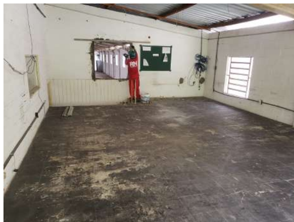
(b) Almoxarifado antes da reforma.
