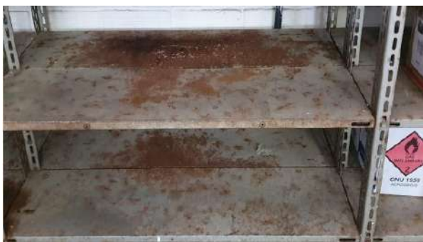
(a) Almoxarifado antes da reforma.
