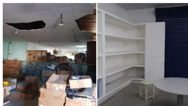
(b) DIPA antes e depois da reforma.
